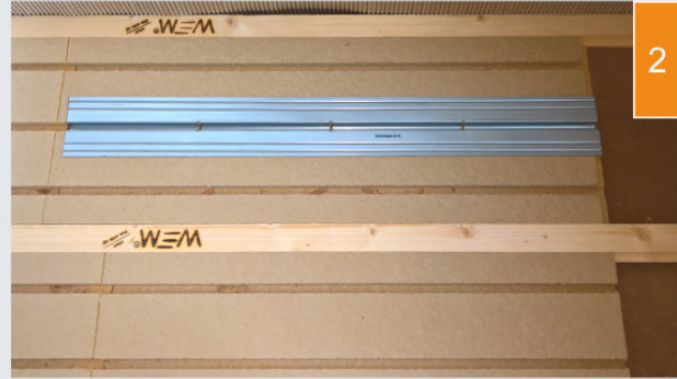
(2) Warmtegeleidende metaalplaten worden in de vloerplaten gelegd.
