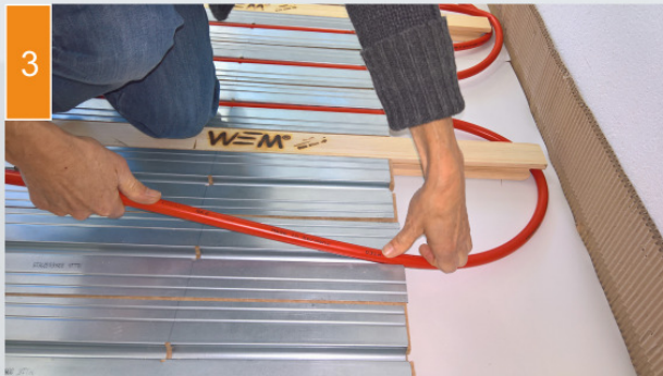
(3) De buis wordt in de warmtegeleidende metaalplaat gelegd en op de verdeler of Multibox aangesloten.
