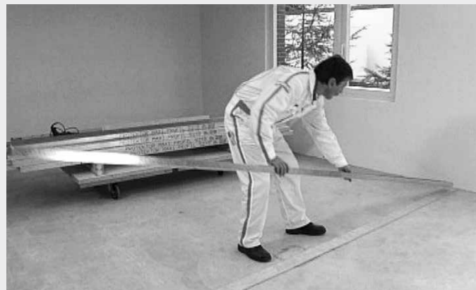
Het aanbrengen van de U-vormige randprofielen op de vloer op isolatieband
