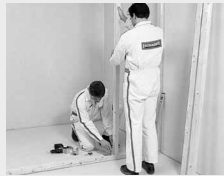
Montage van houten regels met steeknagels of hoekijzers
