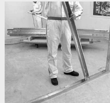
Montage van de CW-profielen
