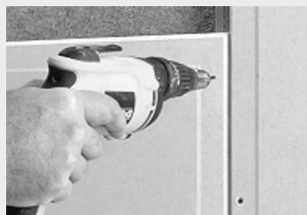
Vastschroeven op een stalen onderconstructie
