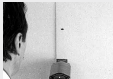
Vastnieten van fermacell op fermacell
