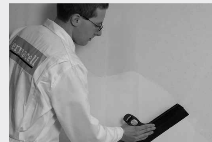
Wandafwerking met fermacell Kant-en-klaar finish en met fermacell Gips-dunpleister
