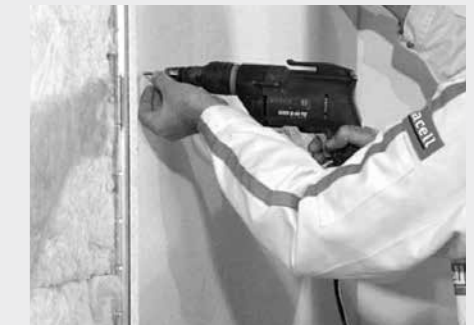
Aanzetten van de snelbouwschroefmachine
