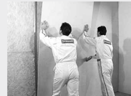
Beplating van de metalen onderconstructie
