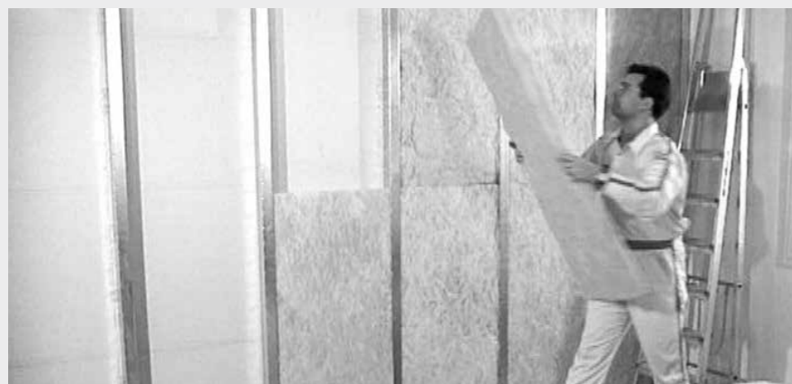
Aanbrengen van isolatieplaten
