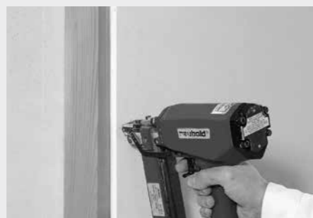
Vastnieten op een houten onderconstructie
