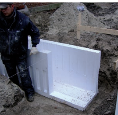
Uitgraven bouwput en plaatsen PS bekistingselementen
