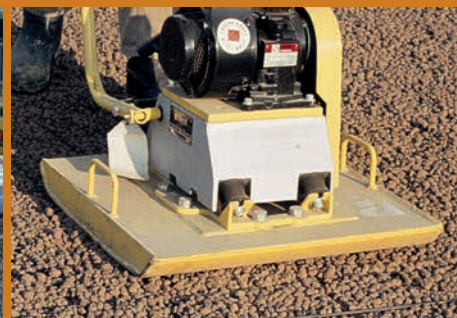
Wapeningsnet als voorlopige werkvloer
