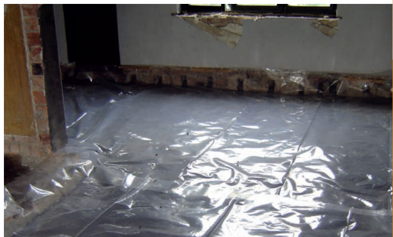
Vervangen houten vloeren
