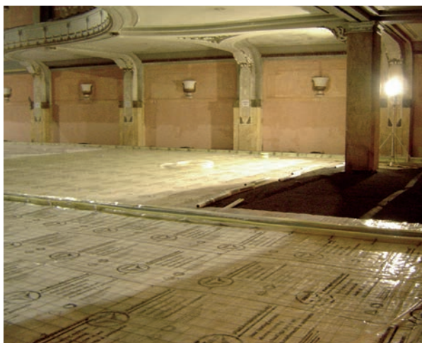
Vloerverwarming, renovatie Roma, Borgerhout
