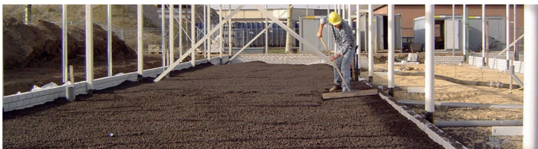
Industriebouw dubbele wapening
