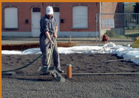
Stabiliseren met cementmelk
