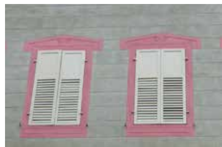
FLP-L Historische kalkpleister met lichte toeslagstoffen als grondlaag op kasteel Hershheim, Worms
