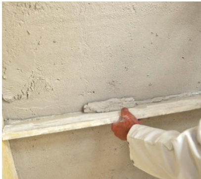
Aanbrengen met de regel
