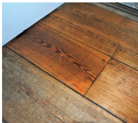
Cire de lin incolore sur du bois ancien. Avant et après le traitement.
