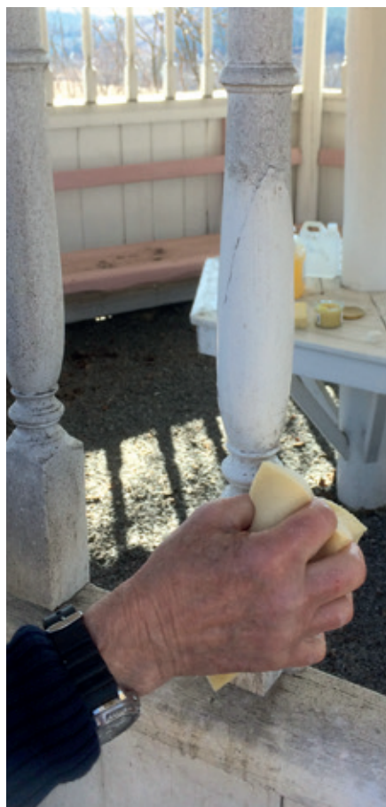
Avant de peindre, nettoyez méticuleusement les surfaces brutes et peintes.
