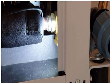
Schieben Sie die Isolierhülse zurück, um den Sensor abzudecken, und verlegen Sie das Kabel zum Steuergerät.
