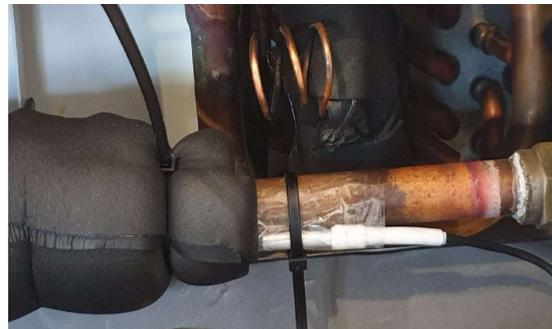
Sensor auf Kupferrohr aufsetzen
