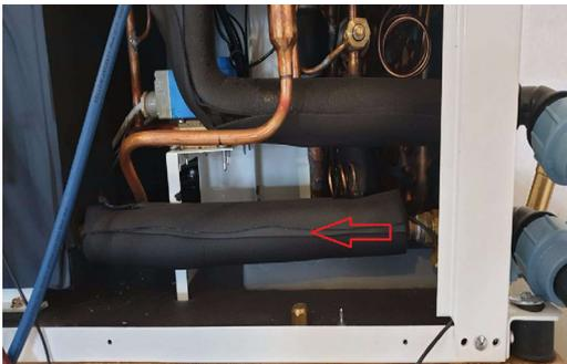
Isolierung so weit wie möglich nach hinten verschieben
