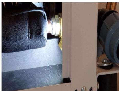
Déplacez l'isolation vers l'arrière aussi loin que possible
