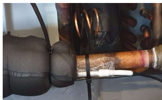
Placez le capteur sur le tuyau en cuivre
