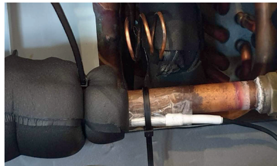
Coloque el sensor en la tubería de cobre
