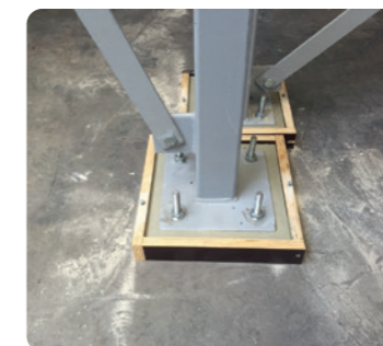
Krimpvrije gietmortel - Ondergieten van staalconstructies en machines
