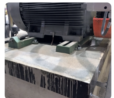
Krimpvrije gietmortel - Ondergieten van staalconstructies en machines
