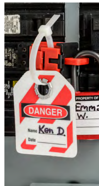
Beveiliging met kabelbinder en/of hangslot
