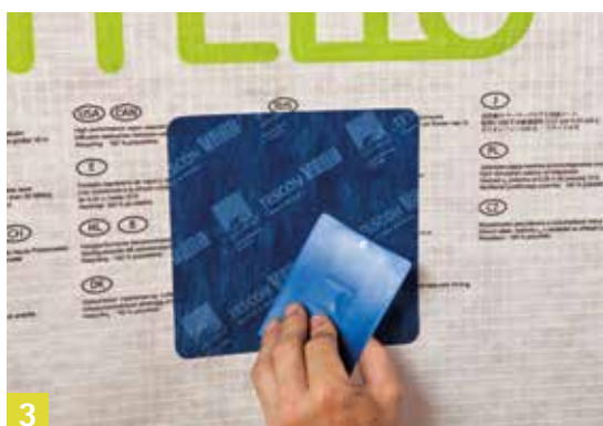
3 Stevig aanwrijven met de aandrukhulp pro clima PRESSFIX
