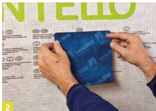
2 TESCO VANA patch verlijmen
