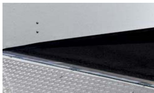
Bodem van gegoten estrik
