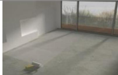
Maak de ondergrond schoon en egaal, waar de folie wordt geplaatst. Het is verplicht om isolatie te plaatsen onder de vloerverwarmingsfolie Quality Heating heeft diverse isolatie mogelijkheden. Ga naar de webshop of neem contact op met de klantenservice. Heeft u een vochtige ondervloer gebruik dan de FastHeat floor primer als voorstrijk middel.
