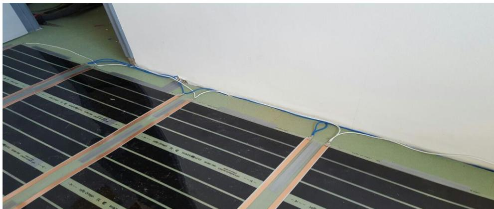
Machen Sie an der Stelle, an der der Thermostat über den Boden montiert wird, zwei Schlitze in der Wand. Die Anschlusskabel der Fußbodenheizungsfolie verlaufen durch den einen Schlauch und der „Sensor, Fußbodenfühler“ durch den anderen.
