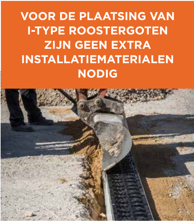
Plaatsing van een I-type roostergoot
