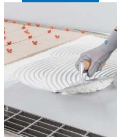
Aanbrengen van de vloer- of wandbekleding met Kerapoxy Design
