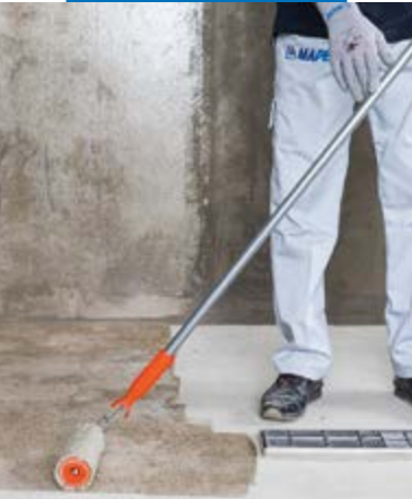
Aanbrengen van Primer SN op het oppervlak
