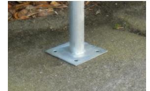
Version inox: Tube en acier AISI316 Ø 48 mm épaisseur min. 2.5 mm
