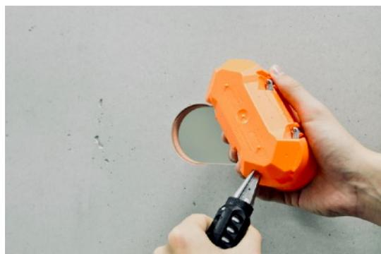
**Schritt 3** Führen Sie die Kabel mit einer Länge von 10-15 cm in die Unterputz-Hohlwanddose ein. Setzen Sie die Dose mit vormontierter Installationsträgerplatte in die Wandöffnung ein.
