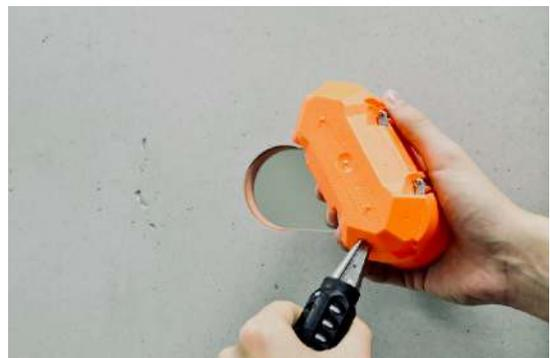
**Schritt 3** Führen Sie die Kabel mit einer Länge von 10-15 cm in die Unterputz-Hohlwanddose ein. Setzen Sie die Dose mit vormontierter Installationsträgerplatte in die Wandöffnung ein.
